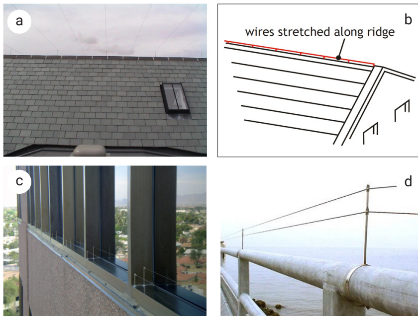
Figura 11. Esempi di installazione di fili ballerini (bird wires) su tetti (a e b) e parapetti (c) degli edifici ed altre strutture (d) tipicamente utilizzate dai gabbiani come posatoi (ad es. corrimani dei ponti). Fonti delle immagini a) https://www.ecoltd.net/seagull-deterrents ; b) Gloucester City Council 2005; c e d) Pacific Grove, CA ( cityofpacificgrove.org ) (data di accesso 29/08/2022).
